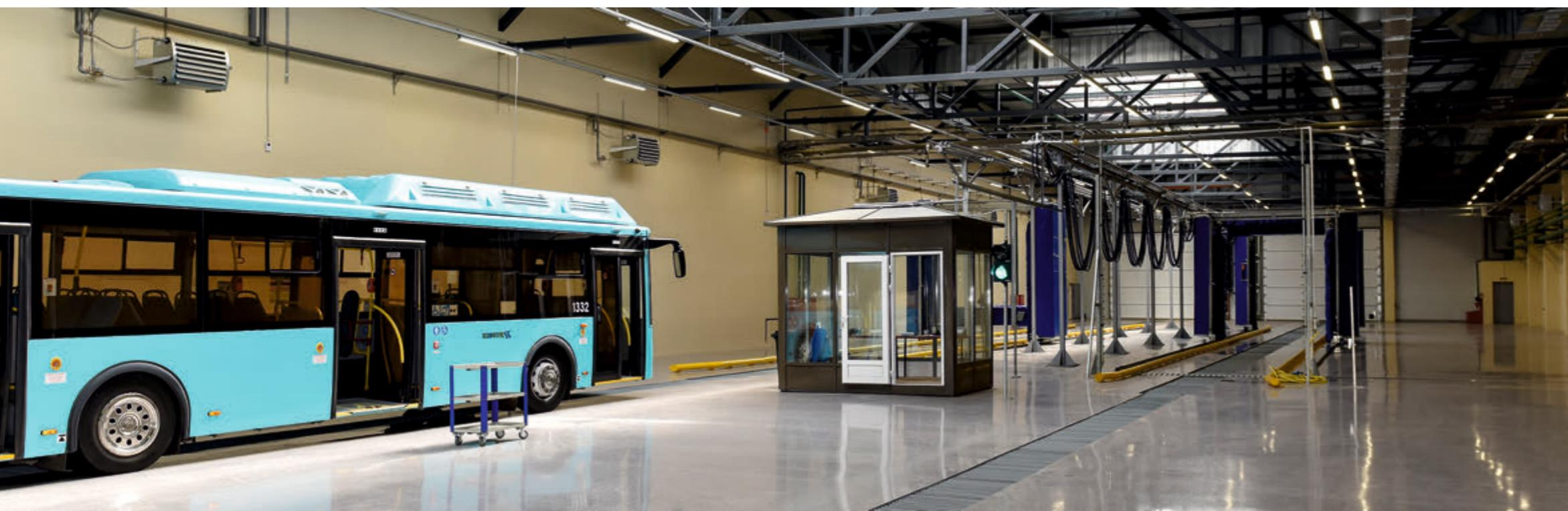
**М**оечный комплекс предназначен для внешней мойки пассажирского транспорта автобусов, электробусов, троллейбусов.
